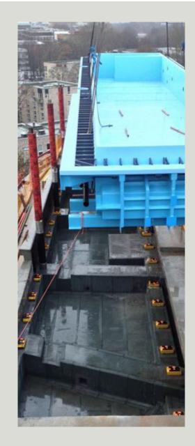
Los elementos de muelle GERB se suministran e instalan generalmente pretensados. Esto proporciona una ventaja significativa durante la fase de construcción, ya que permite realizar ajustes en una etapa posterior, siempre que los elementos permanezcan accesibles. Esta flexibilidad garantiza que la instalación se pueda adaptar para cumplir con requisitos específicos y mejora la longevidad de la estructura.
